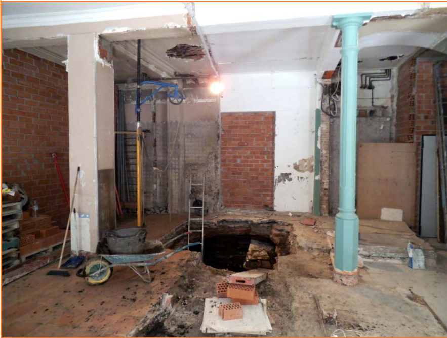
Foto 7. Vista de proximitat del rebaix on s'observen els pilars del forat de l'escala.
