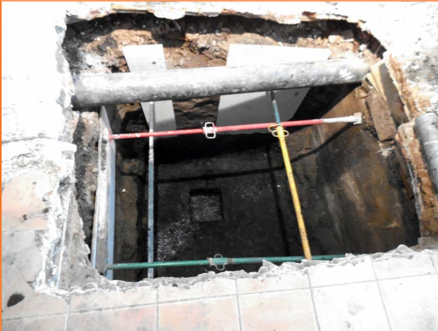
Foto 9. Vista final del rebaix on es pot veure el fons de la fossa sèptica UE 103.
