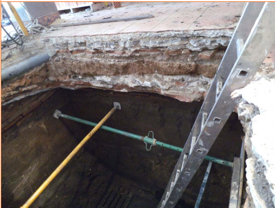
Foto 8. Vista de detall de la secció de la volta de la fossa sèptica 103.
